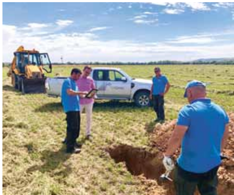
Mitarbeiter der WeGrow AgriTec S.L. planen die Installation der Bewässerungsanlage auf einer neuen Anbaufläche der KiriFarm Spanien
